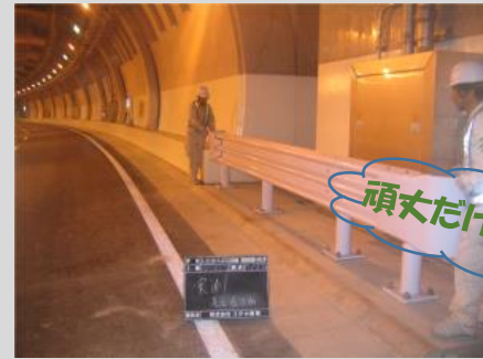
首都高内のガードレール
