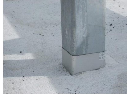
角柱への設置
