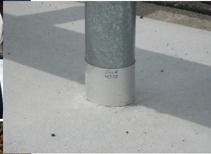
丸柱への設置
