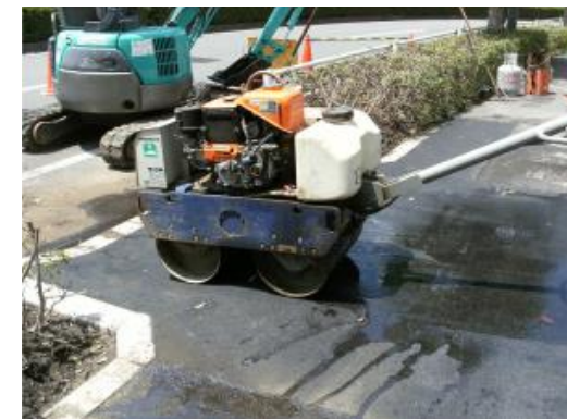
歩道切り下げ工
