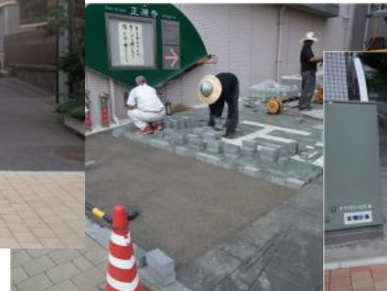
インターロッキングブロック舗装工
