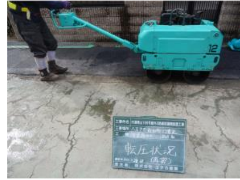
アスファルト舗装改修工
