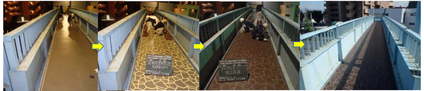
歩道橋鏡面舗装工(型枠式タイル工法)
