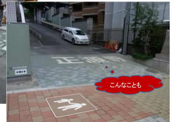
インターロッキングブロック舗装工
