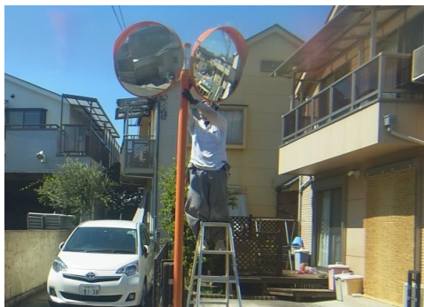
カーブミラー設置
