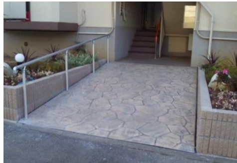
手すりの設置
