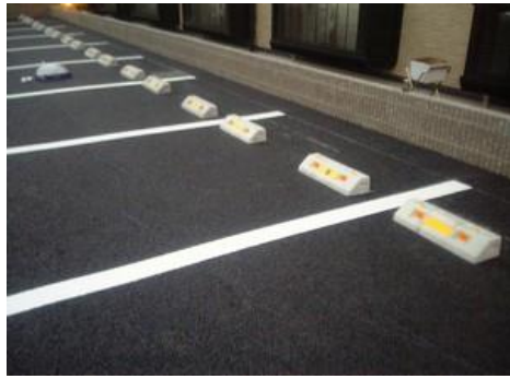
駐車区分線及び車止めブロック設置
