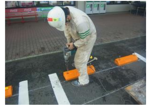
車止めブロック設置工事 ※各種ブロックを取り揃えています
