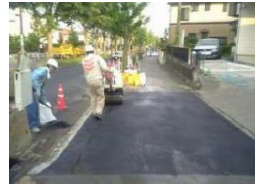
駐車場出入口歩道切り下げ工事 ※計画から自費工事申請まで行います
